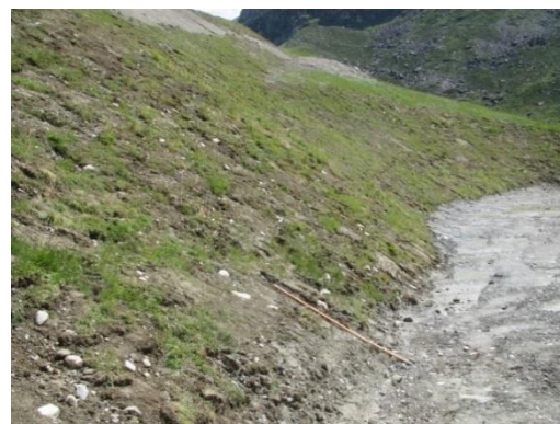
Ci-contre : Talus végétalisé par étrépage : Après travaux (Aout 2016) et 1 an après la fin des travaux (2017)
