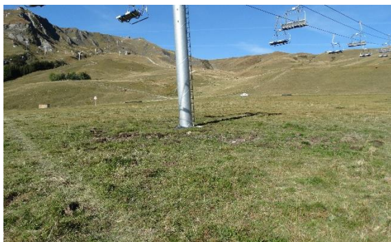
Emprise de fouille de pylône et tranchée de réseau d'adduction revégétalisés par étrépage (contexte de zone humide) : 1 an après travaux (2017)
