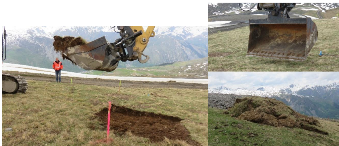
Test d'étrépage, godet plat et stockage des mottes (KARUM, Mai 2018)
