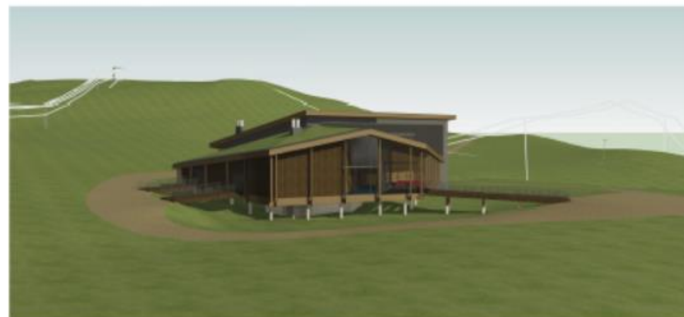
Vue Sud Ouest
