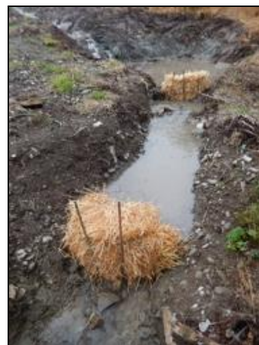
Figure 1 - Exemple d'un système de filtration d'un cours d'eau. Crédit : KARUM
