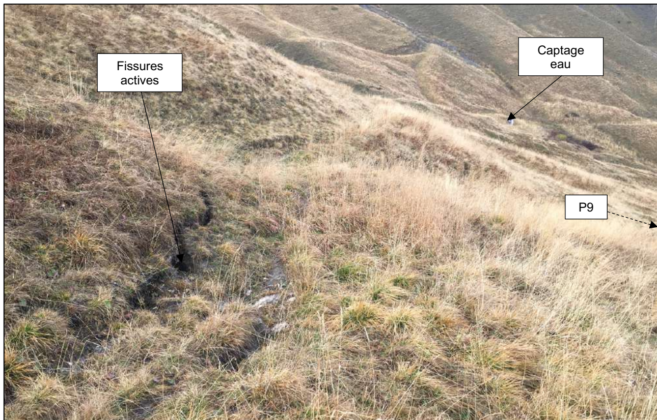
Photographie 14 : Fissures actives en amont et au Sud du futur P9
