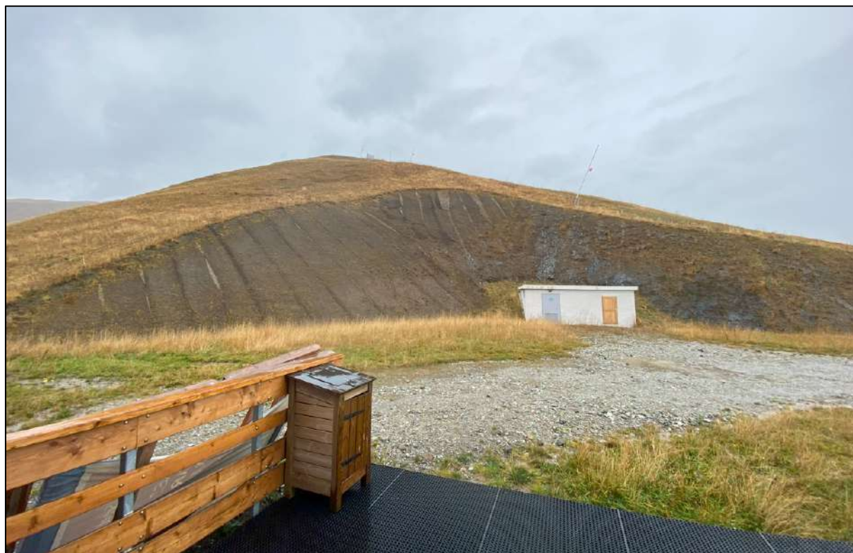
Photographie 3 : vue générale talus déblais G2 TC « Côte du Bois »
