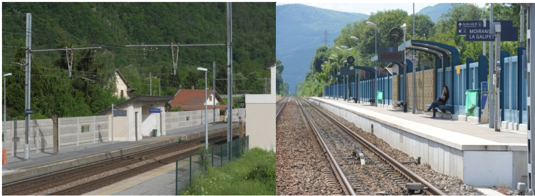
Exemples d'écrans acoustiques à Aiguebelle et Moirans
