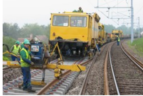
Longs Rails soudés sur traverses béton
