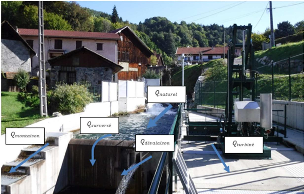
Figure 10 : Illustration des débits mesurés à la prise d'eau
