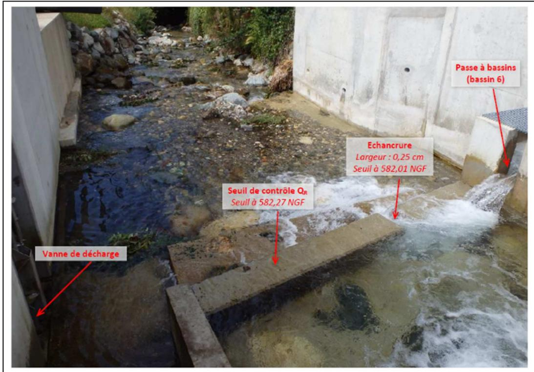
Figure 6 : Vues détaillées de la prise d'eau
