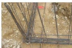
Nœud de chaînage - Continuité mécanique
