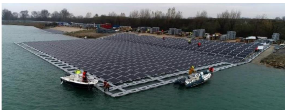
Phase de mise à l'eau (Plan d'eau de Piolenc - 84, Ciel-et-Terre)
