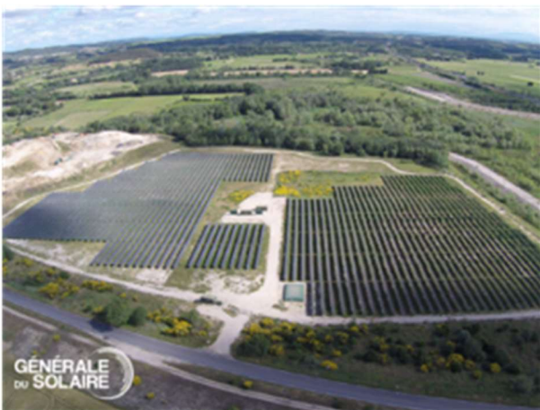
Centrale de Pujot, Gard
