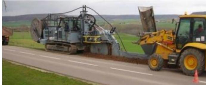
Figure 136 : Réalisation de la tranchée (source : GÉNÉRALE DU SOLAIRE, 2023)
