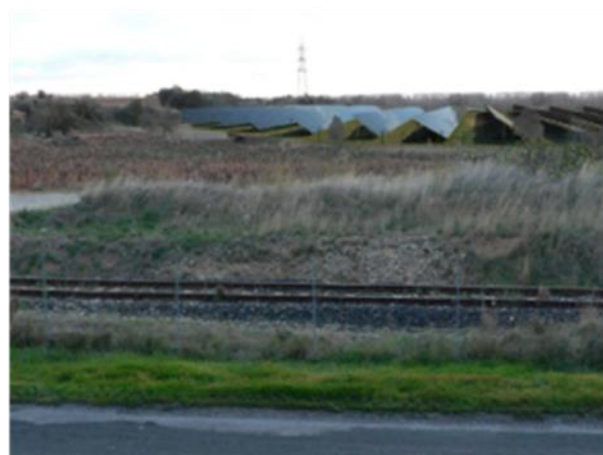
Centrale de Narbonne, Aude
