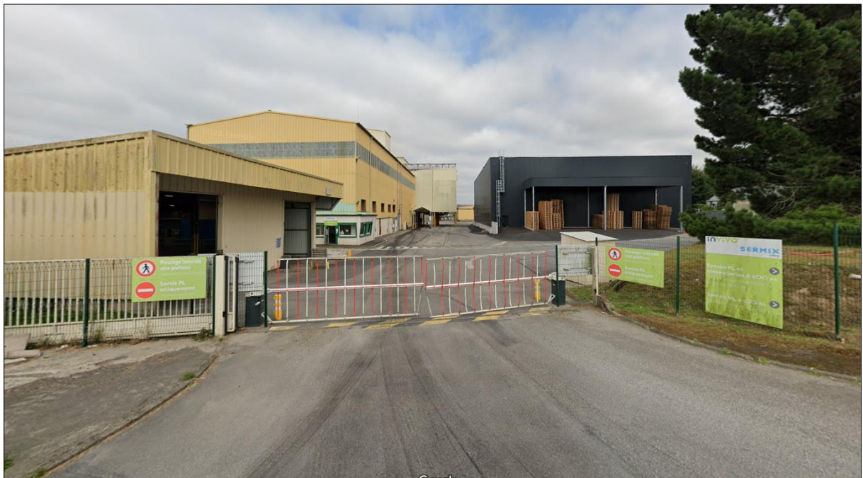
Figure 20 : Vue de la sortie des poids lourds et véhicules de messageries depuis la rue de Calouët (source : Google StreetView, août 2021)
