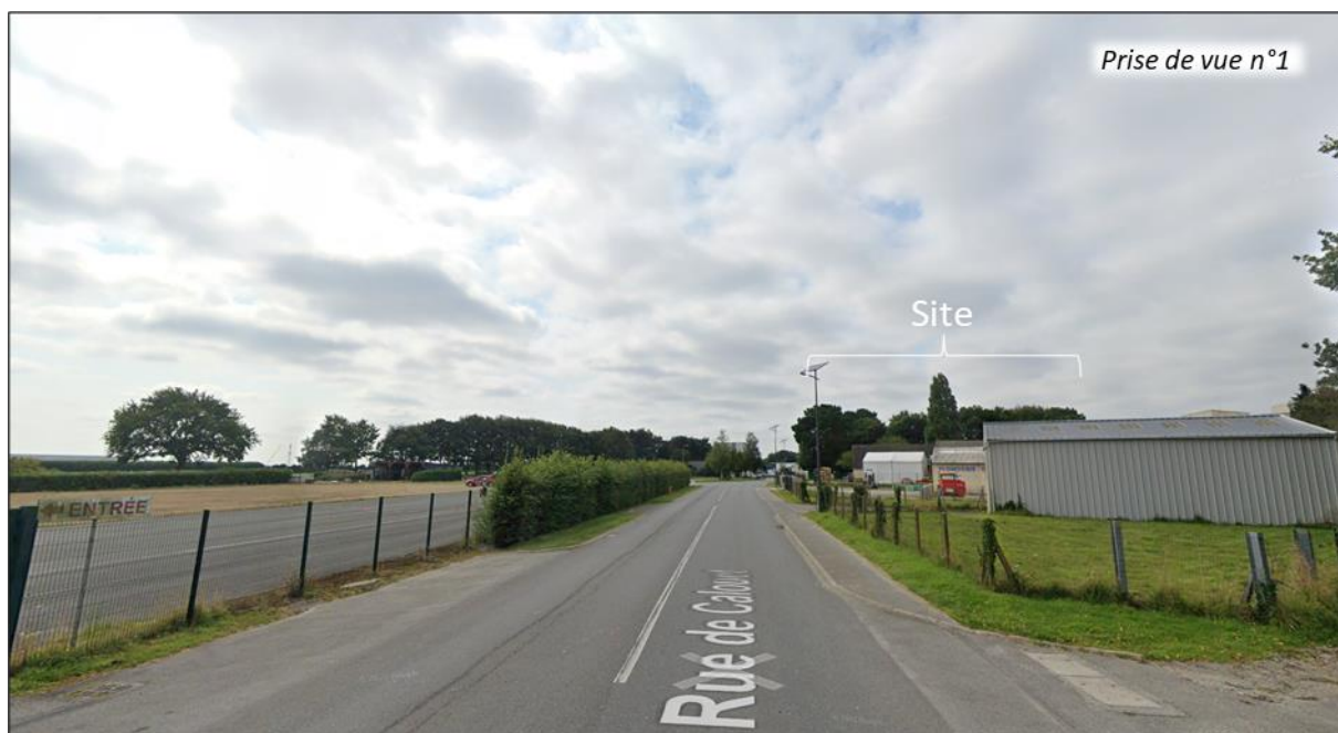
Figure 75 : Vue éloignée depuis la RD41 - rue de Calouet en direction du site (source : Google StreetView, août 2021)
