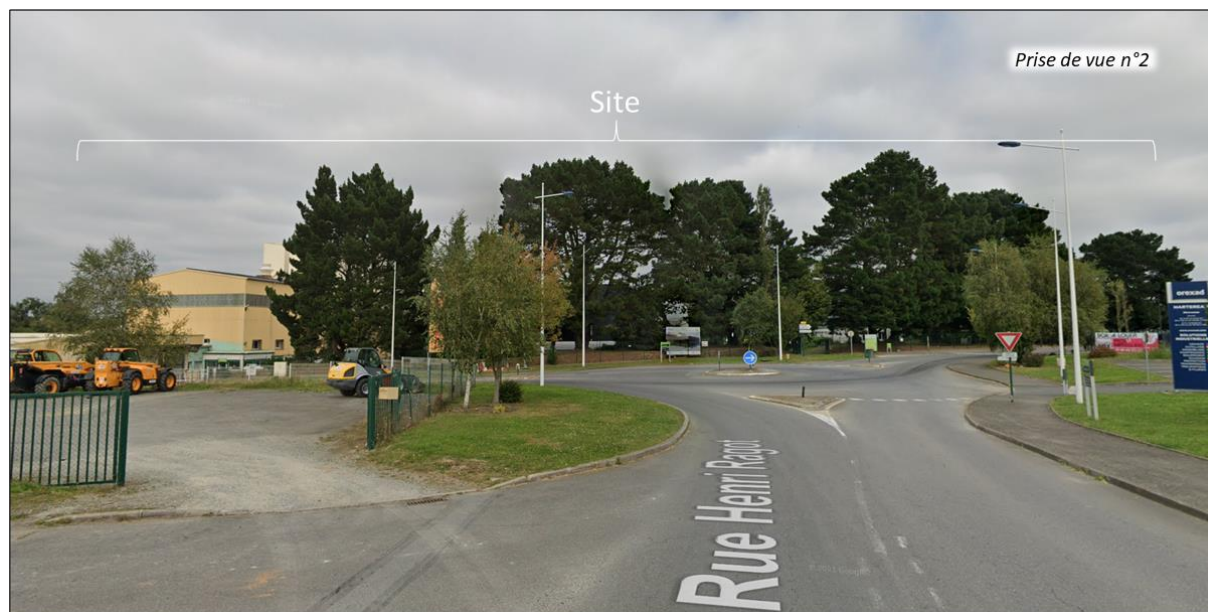
Figure 76 : Vue rapprochée depuis la rue Henri Ragot en direction du site (source : Google StreetView, août 2021)
