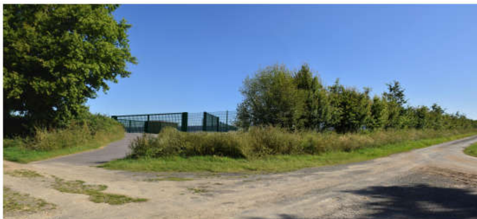
Vue 4 / Installation panneaux photovoltaïques et clôtures
