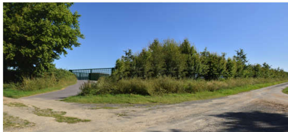
Vue 4 / Après travaux - Installation panneaux photovoltaïques et clôtures + Aménagement paysager
