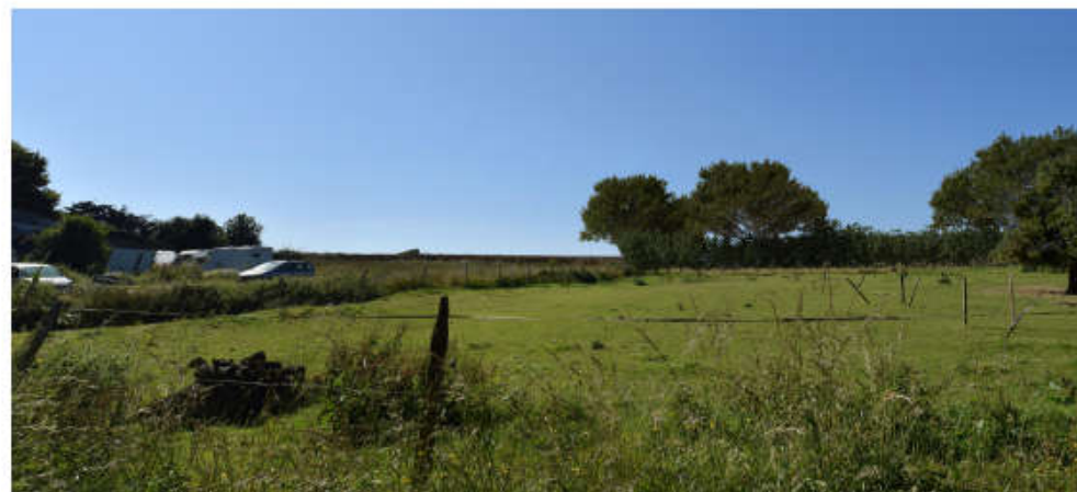
Vue 1 / Après travaux - Installation panneaux photovoltaïques + Aménagement paysager
