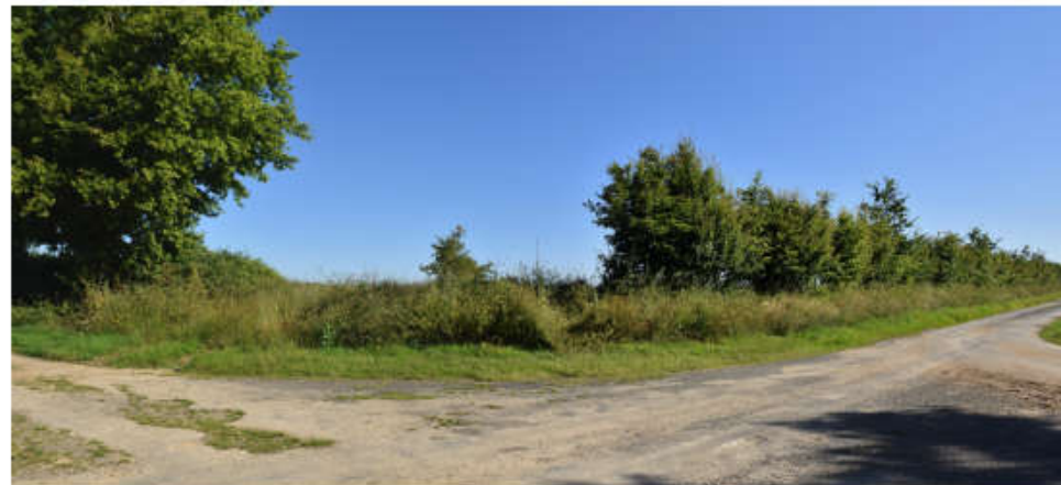
Vue 4 / Avant travaux
