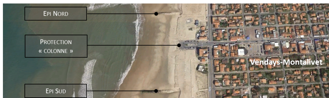
Figure 3 : Localisation des ouvrages rencontrés sur le littoral de Vendays-Montalivet (source : CASAGEC INGENIERIE)
