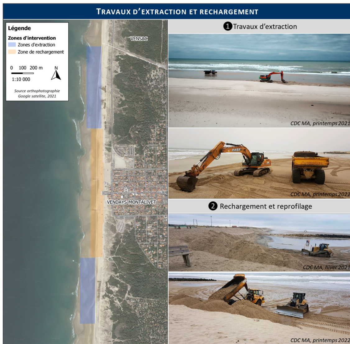
Figure 6: Localisation des secteurs d'extractions et rechargement, et photographies des dernières opérations réalisées (CDC MA).
