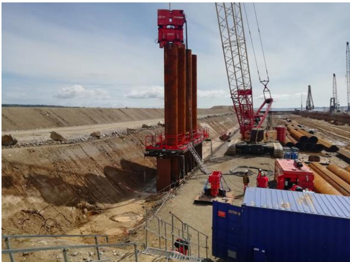
FIGURE 23 : EXEMPLE DE MISE EN ŒUVRE DE RIDEAU METALLIQUE / COMBIWALL (SOURCE : EGIS)
