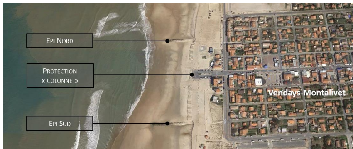
Figure 3 : Localisation des ouvrages rencontrés sur le littoral de Vendays-Montalivet (source : CASAGEC INGENIERIE)
