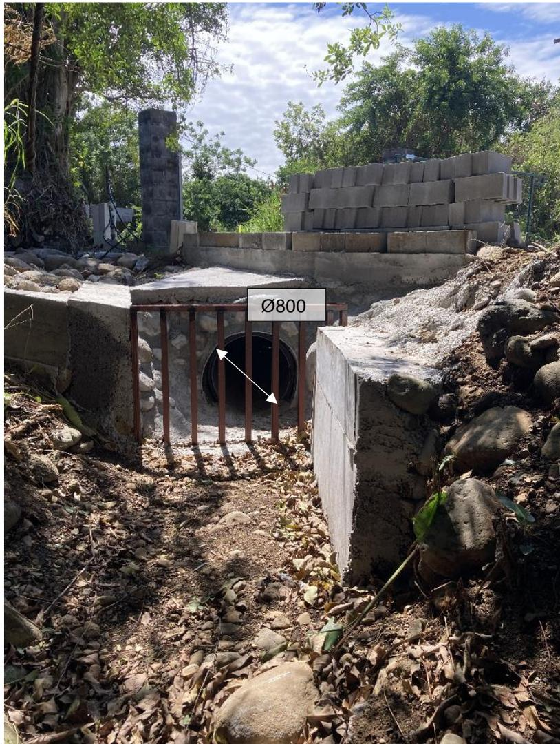
*Figure 5 - Buse en PVC et grille situées à l'extrémité aval du canal*
