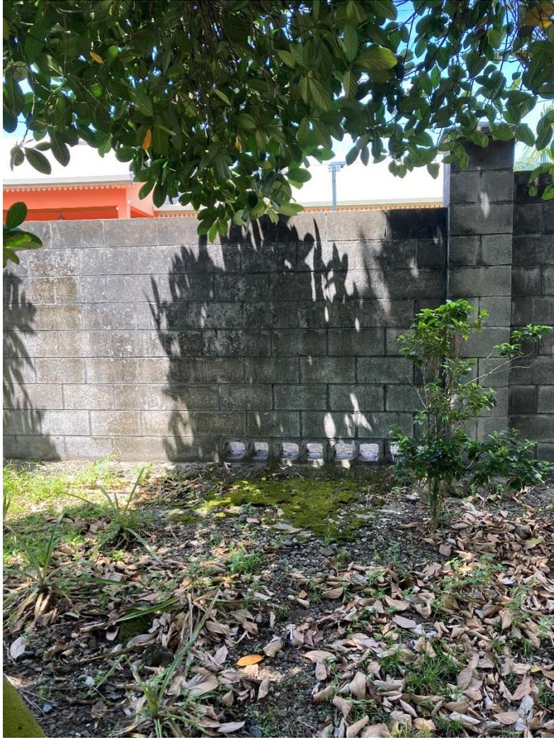
*Figure 10 – Mur de clôture en limite amont de la parcelle AY1065 avec ouvertures à sa base favorisant la transparence hydraulique*
