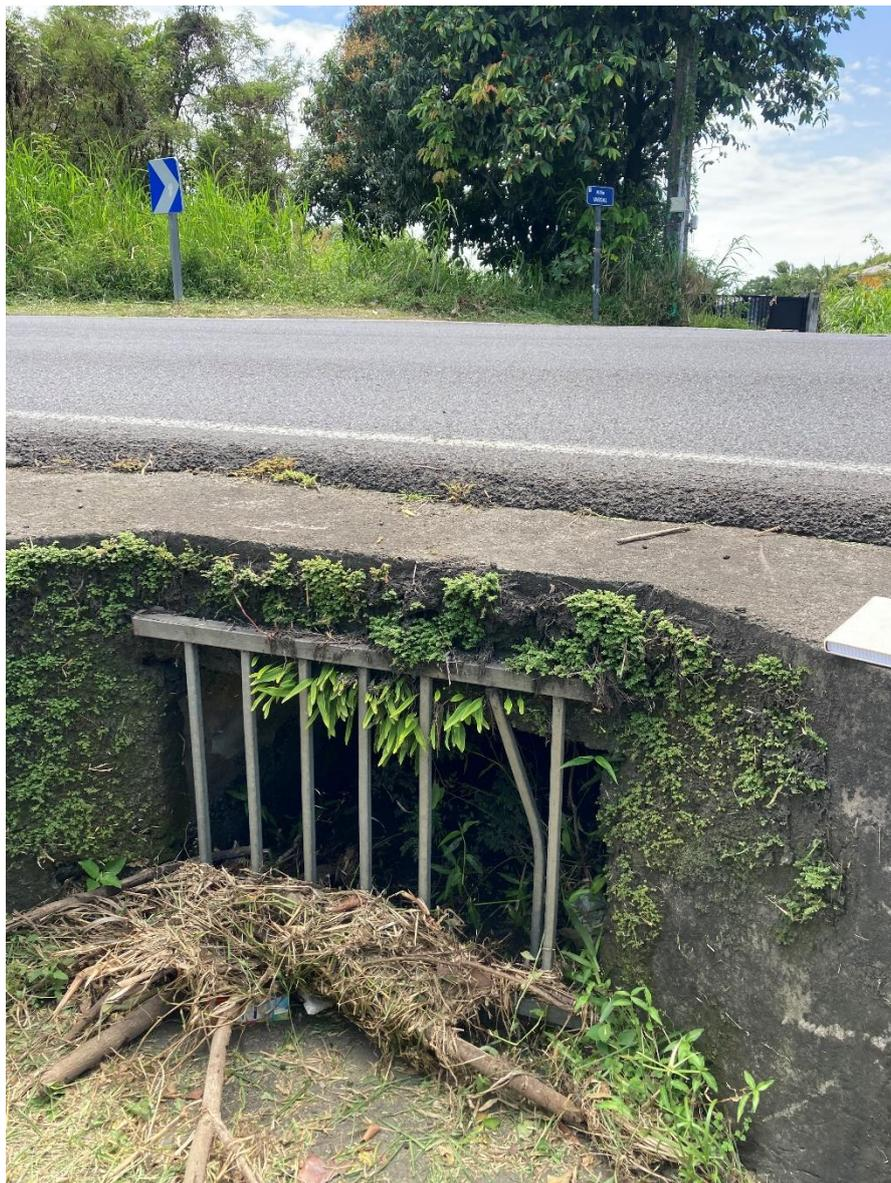
*Figure 11 - Dalot partiellement obstrué au niveau de l'accotement de la RD47 et vue vers l'intersection avec l'allée Vassal où s'écoulent les eaux de débordement.*
