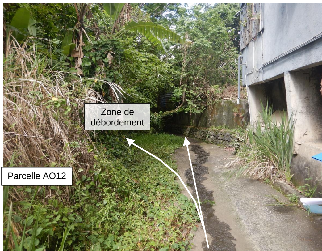
Figure 11 – Vue du canal vers l'aval et zone de débordement
