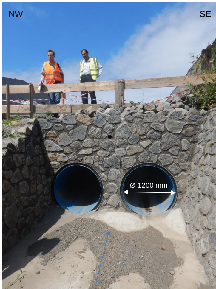
Figure 19 – Buses diamètre 1200 mm à l'entrée de la zone couverte sur la parcelle AX851.
