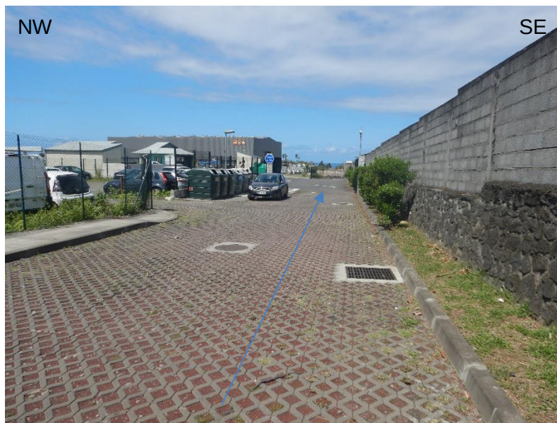
Figure 17 – Canal déjà couvert au niveau de la déchetterie (parcelle AX765)
