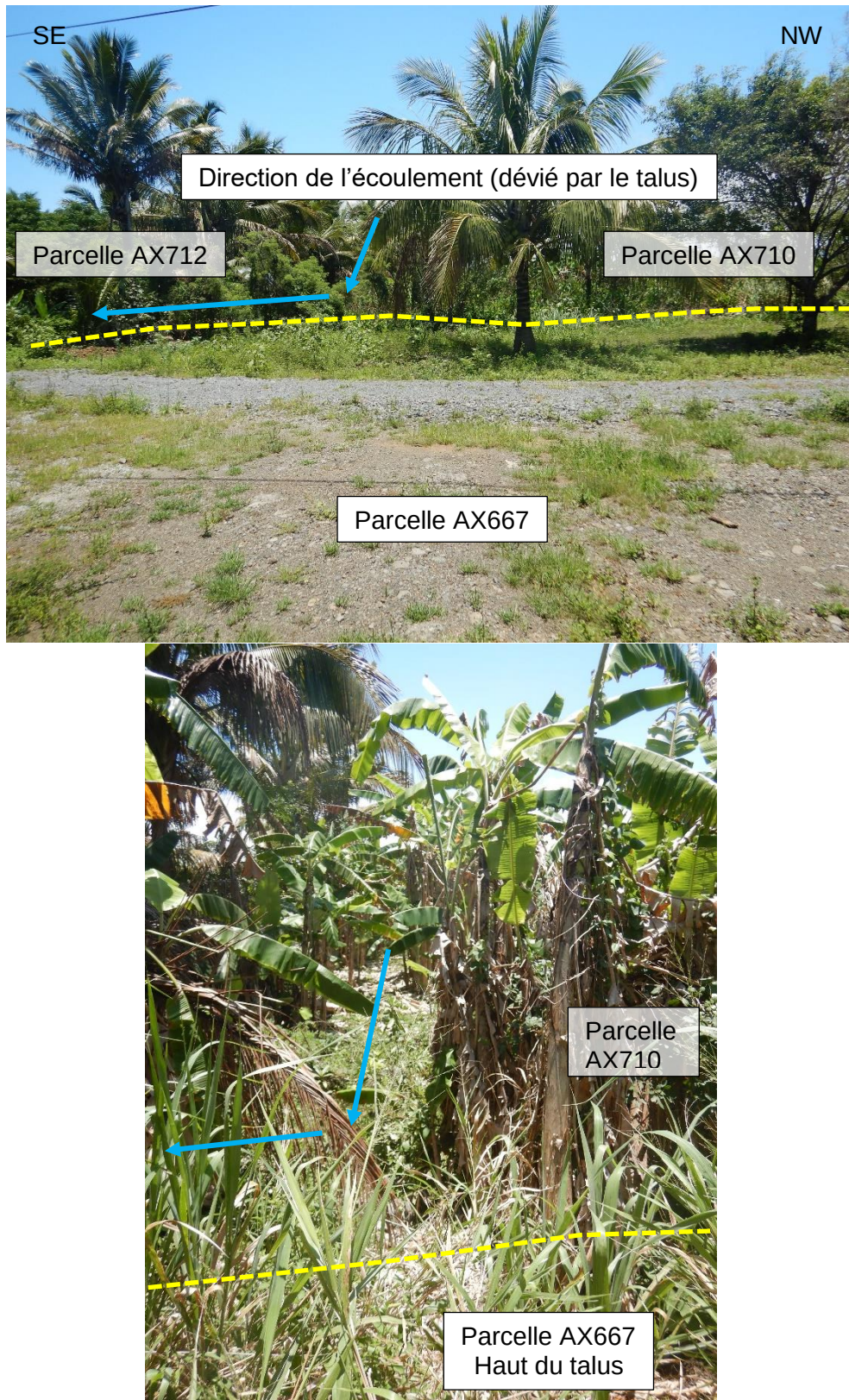
Figure 7 – Vue sur la bordure amont des parcelles du requérant et présence d'un talus en remblai de 1 m environ
