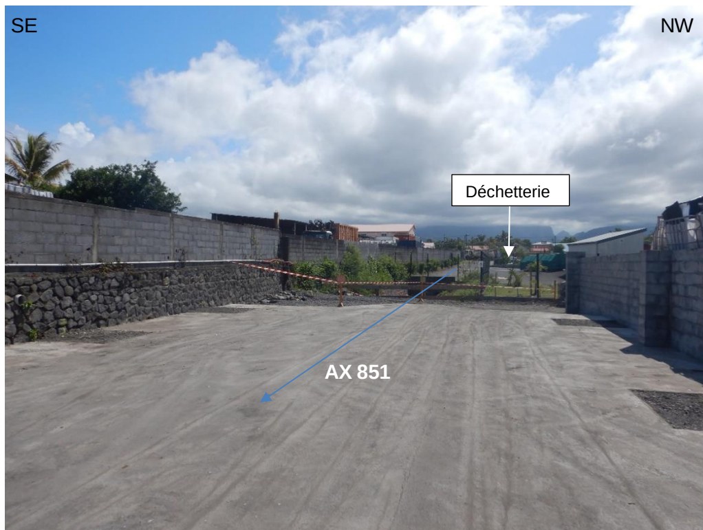
Figure 20 – Partie couverte du canal sur la parcelle AX851 (vue vers l'amont)
