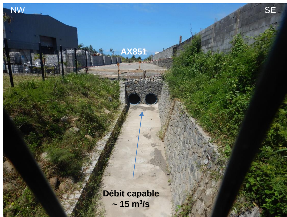
Figure 18 – Partie aérienne du canal entre les parcelles AX765 et AX851 (RVE)
