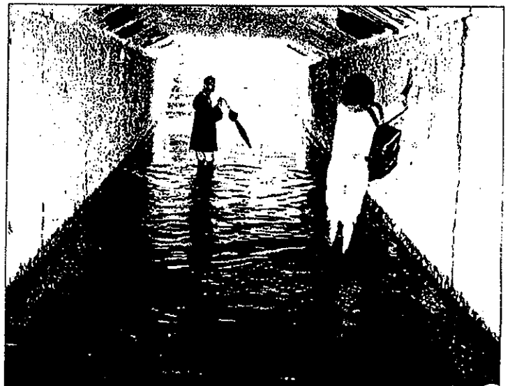
Passage interdit pour les élèves de maternelle. Au centre du tunnel reliant le chemin du centre à différentes écoles de Saint-André, plus d'un mètre d'eau.
