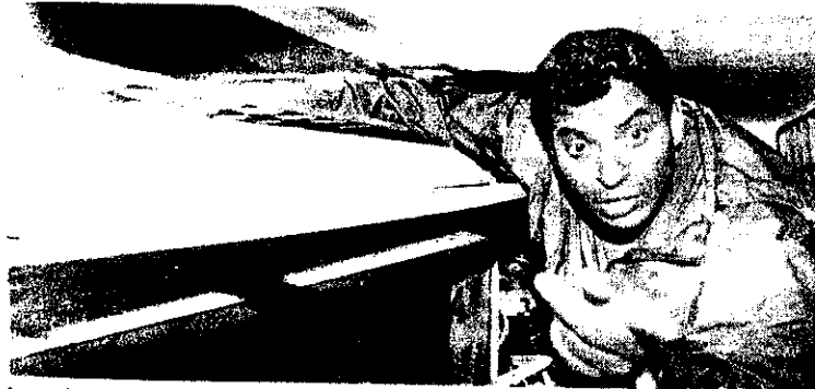
Le mari de la gérante du magasin Symbiose montre par où l'eau du toit du centre commercial de Saint-André s'est infiltrée. (Photos : Emmanuel GRONDIN)
