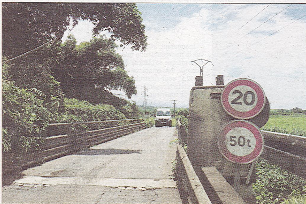
Le pont Bailey doit laisser place à un ouvrage pérenne.
