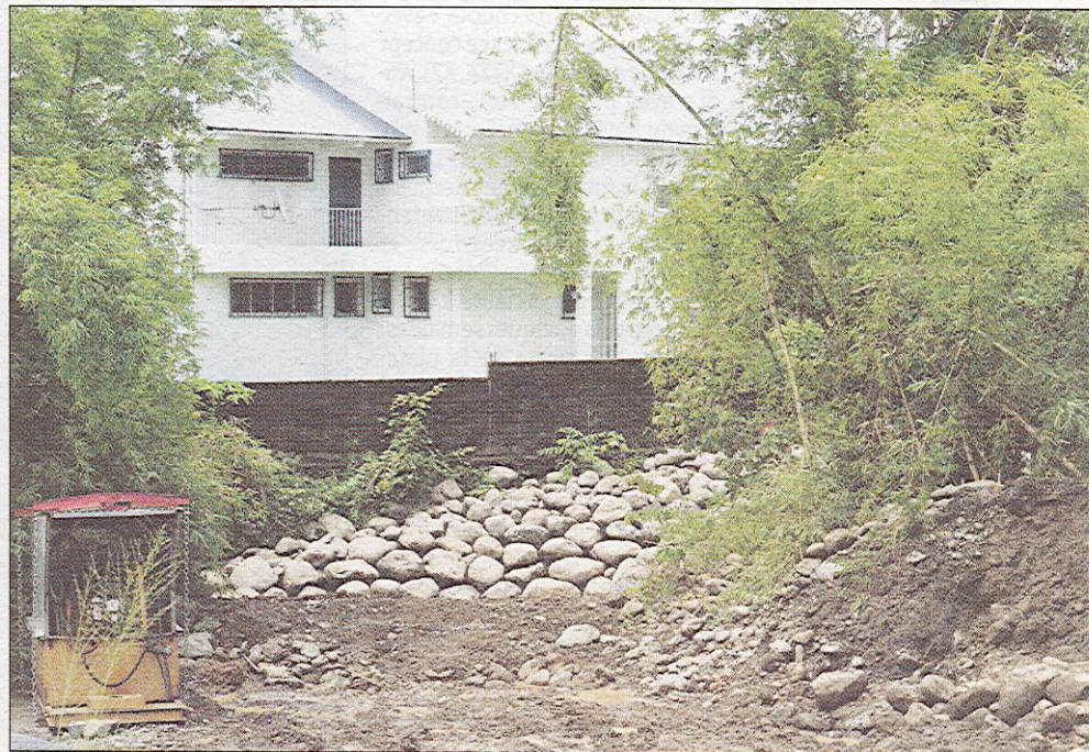
Chemin Morin, des enrochements protègent les murs des habitations. (Photos T.L.)
