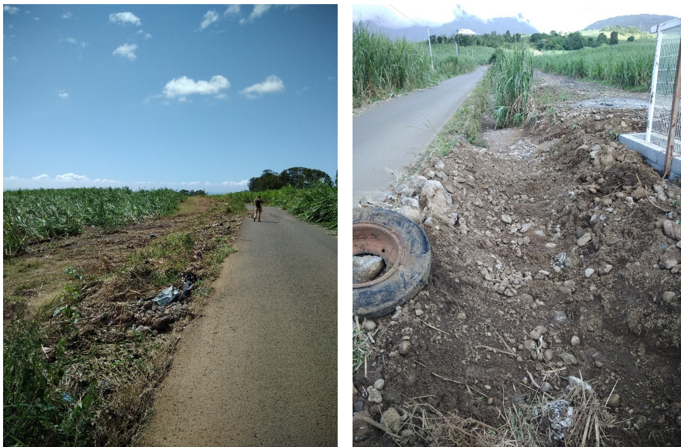
Figure 18 : Ravinement aux abords du chemin Dioré suite au passage de la forte tempête tropicale Fakir (2018).
