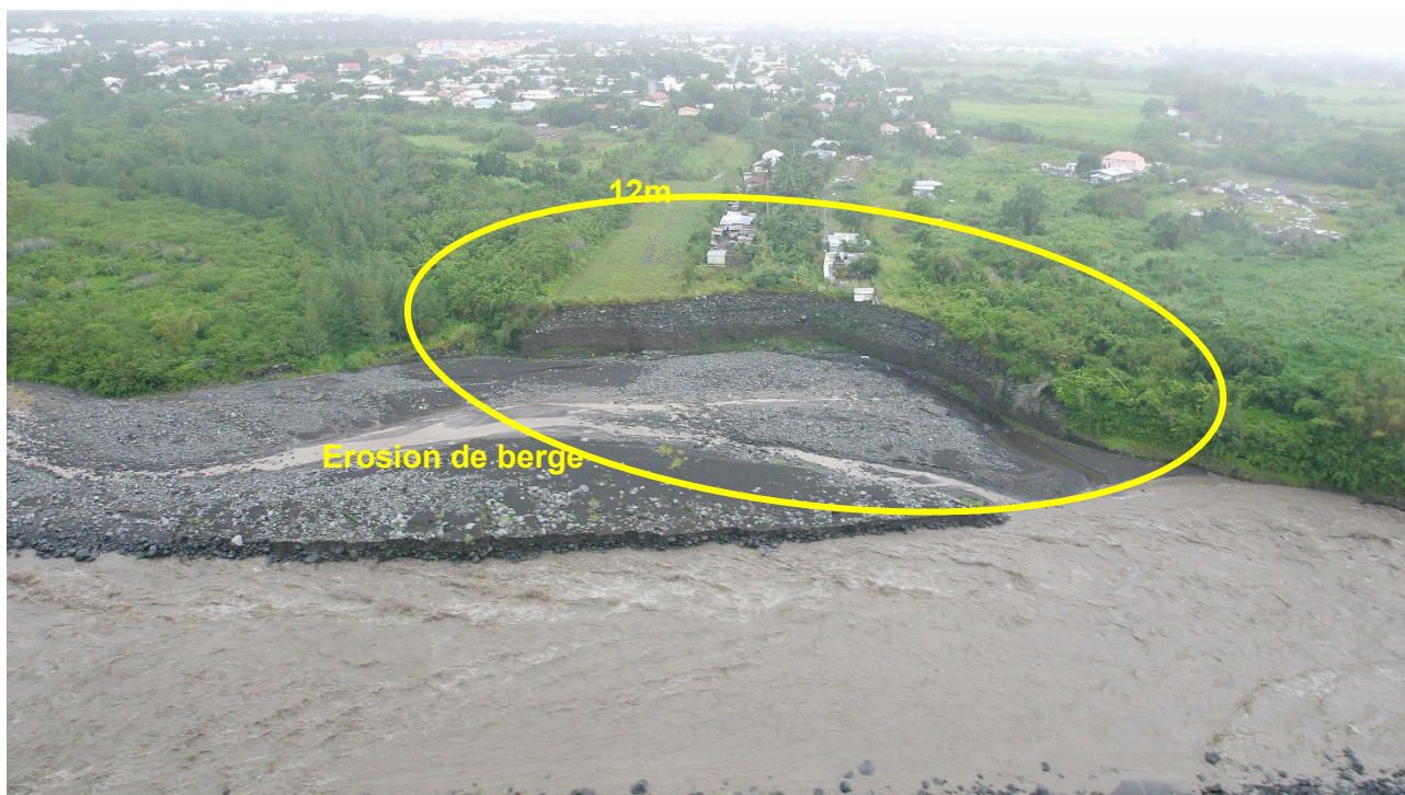
Figure 17 : Lit de la rivière du Mât et berge en rive gauche durant le passage du cyclone Gamède (2007).
