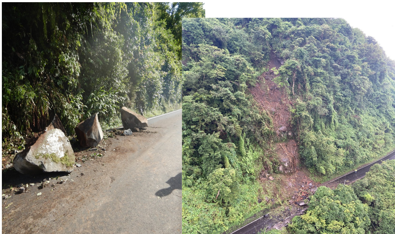
Figure 12 - A gauche : Chute de blocs ayant atteint la RD 48 (Route de Salazie) en 2019. A droite : Eboulement sur la RD 48 en 2021
