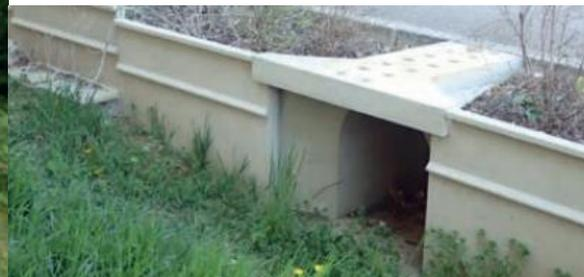
Photo 3 Exemples de passage à faune (Sources : Les passages à faune, guide du CEREMA)
