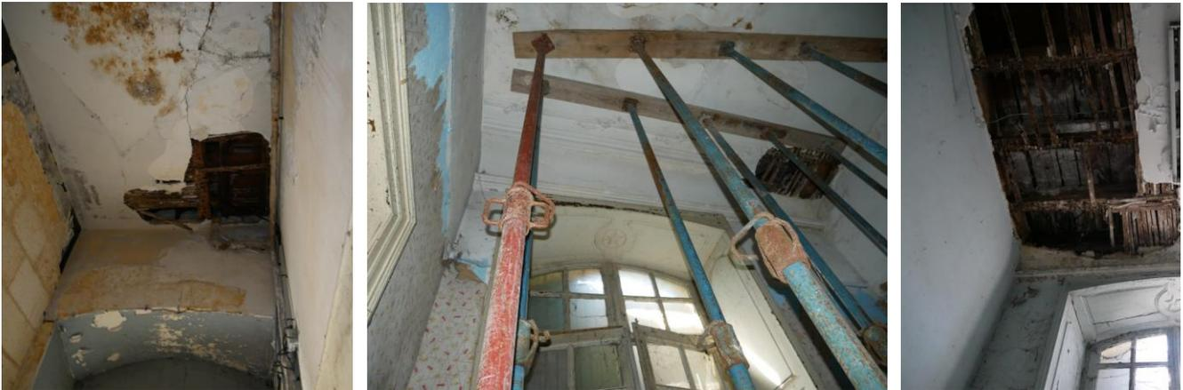
Les plafonds du rez-de-chaussée : dégradation presque totale
