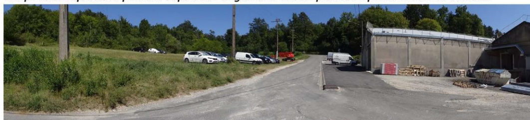
De l'autre côté de la route, l'usine.
