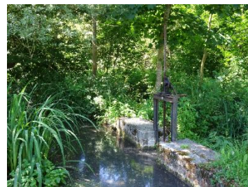
Petite écluse sur l'Echelle à Sers
