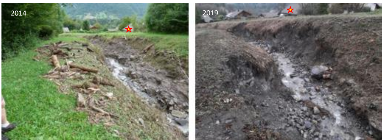
Figure 4 : Comparatif de l'état du lit du Piézan - Photos ONF-RTM
