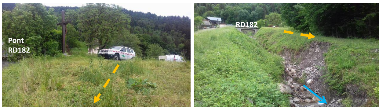
Figure 8 : Accès par l'amont - Photos ONF-RTM mai 2022
