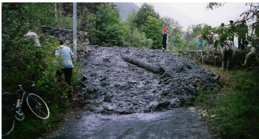
Figure 158 : Arrêt d'une lave après surverse sur une digue (source : étude ETRM)
