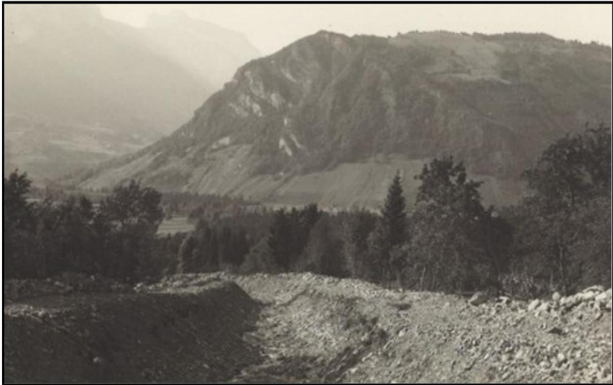
Figure 65: Canal d'écoulement creusé à la pelle mécanique par l'administration des Ponts et Chaussées - juin 1938 - Archives RTM (Source PPRN – Val-de-Chaise)
