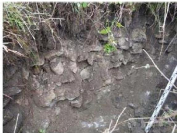
Figure 145 : Fouille à la pelle des matériaux (digue 1RG - RG-TH1) - Source : Etude confluence 2016
