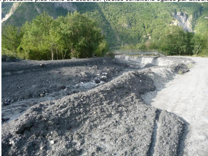
Figure 166 : Arrêt rapide de débordements d'une lave après surverse sur une digue : crue du 22 août 2011 sur le torrent du Saint-Martin à Saint-Martin-de-la-Porte (73) (source RTM)
