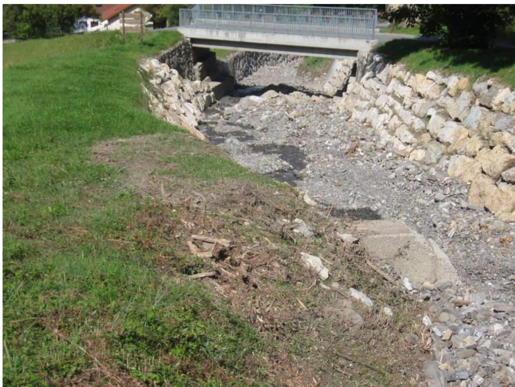
Figure 19 : Dépôt de flottants et de matériaux jusqu'au niveau de crête de l'ouvrage de la digue de l'école
