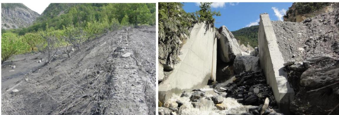
Figure 174 : Exemple de déversement de lave sur digue, avec pas/peu d'érosion (surverse sur digue de fermeture du torrent de Saint Antoine à Modane (73) – source ETRM [4])
