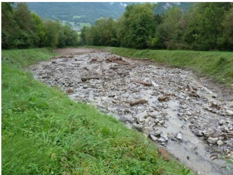
Figure 67 : Dépôt au sein de la plage à la suite de la crue du 8 septembre 2014 (Source : RTM)
