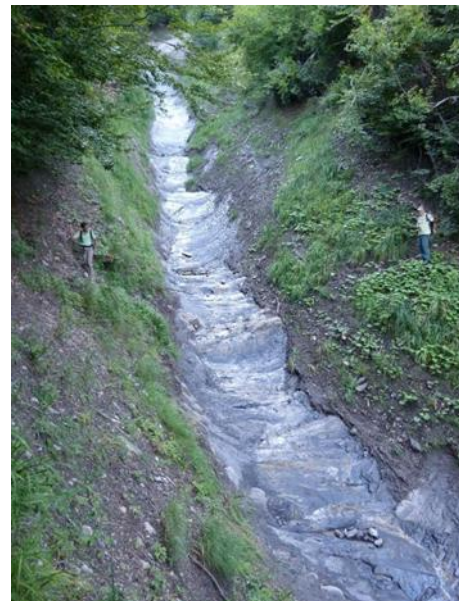
Figure 5 : seuils rocheux dans la branche du Piésan (marno-calcaire) altitude 1200m
