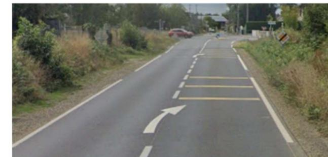
Photo 37 : Exemple de barrettes sonores sécurisant l'approche de l'intersection (intersection RD47 x RD247, Saint-Senier-sous-Avranches)
