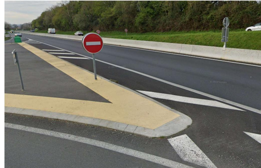
Photo 36 : Exemple de GBA séparant les 2 sens de circulation sur la RD971 à l'approche de l'intersection RD924 x RD971
