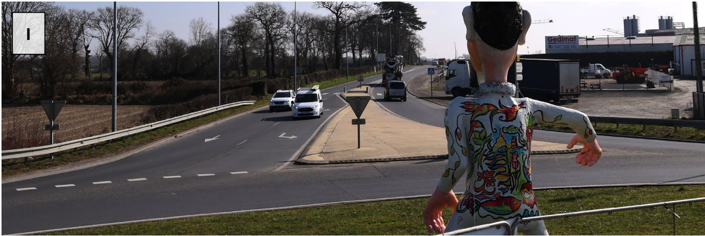
Photo 17 : Vue sur le la RD673 bordant le lieu-dit du Poirier depuis le rond-point de sortie de Saint-Pair-sur-Mer
