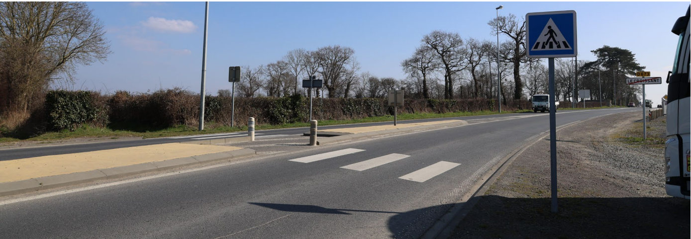
Photo 108 : Traversée sécurisée de la D63 – circuit à cheval la route des abbayes
