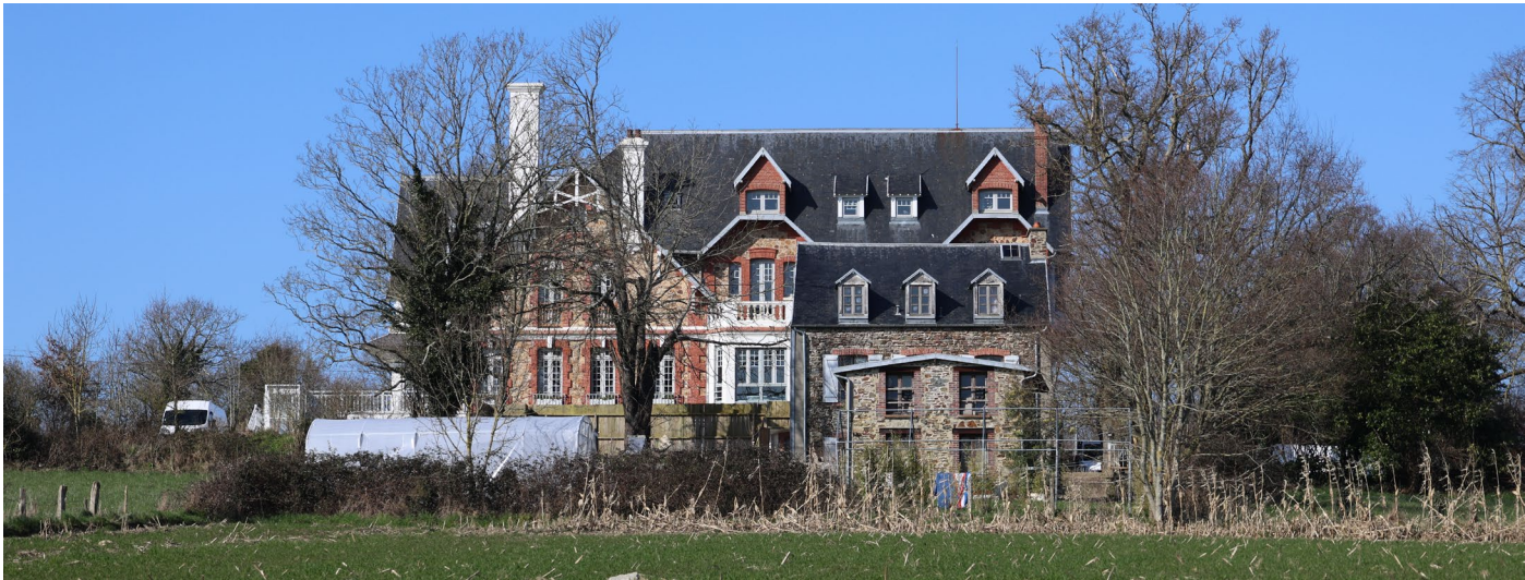
Photo 104 : Vue filtrée par la végétation de la Villa Bonheur depuis la RD572
