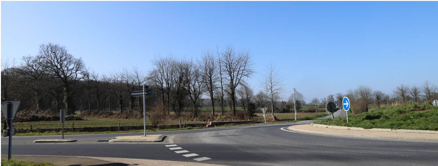
Photo 114 : Aménagement d'un passage piéton en entrée du bourg de Saint-Pierre-Langers sur l'itinéraire de randonnée : route des chiffonniers
