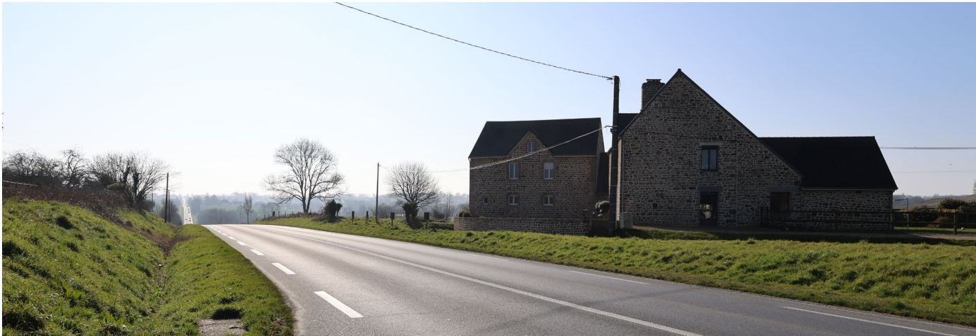
Photo 47 : Vue franche sur la RD673 et l’habitation très proche de la voie
