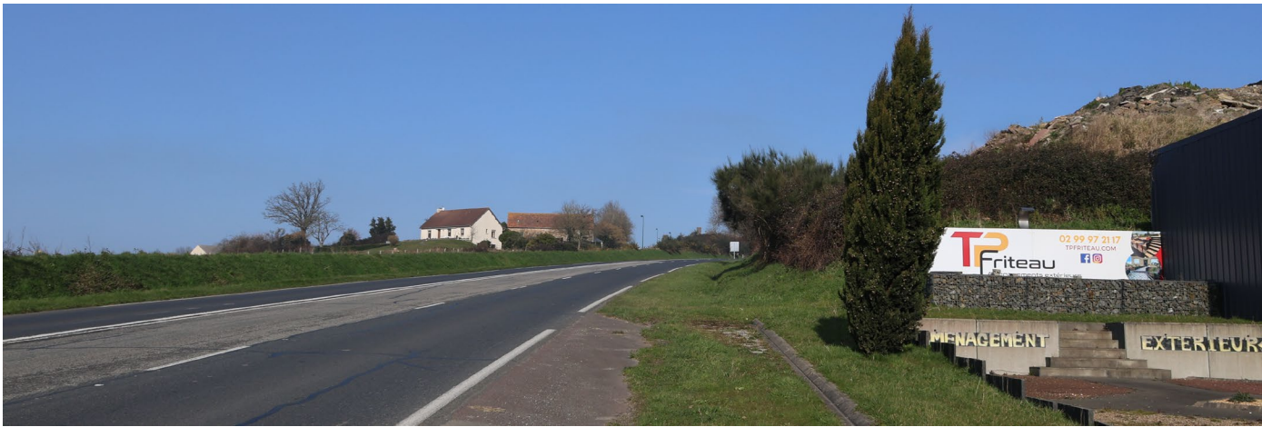
Photo 53 : Vue de l’habitation située en partie sud du hameau de la Boule d’Or depuis la RD673. Sa position en promontoire lui confère une sensibilité élevée
