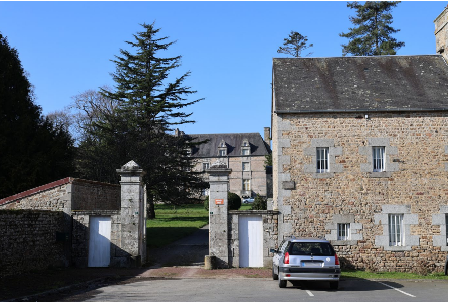
Photo 109 : Le château de Saint-Pierre-Langers
