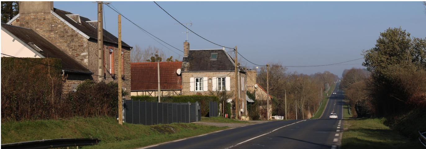
Photo 68 : Les habitation de la Monnerie proches de la RD 673 avec une voirie sur le côté droit plus libre
