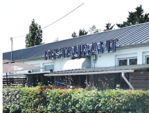
Des enseignes parfois non conformes avec le RNP (enseigne à cheval entre la façade et la toiture = interdit) – Chinon, Zone commerciale du Blanc Carroi
