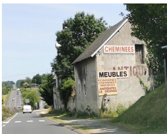
Des enseignes peu qualitatives en façade : plusieurs panneaux à l'esthétique hétérogène – Chinon
