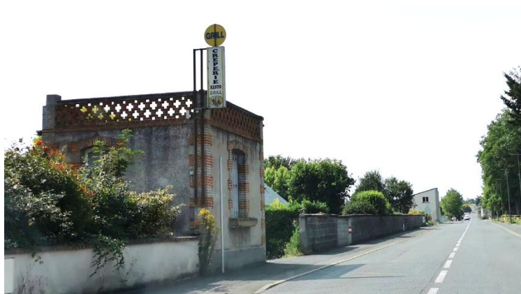
Implantation d'enseigne non conforme avec le RNP, sur une annexe bâtie d'intérêt architectural – Beaumont-en-Véron
