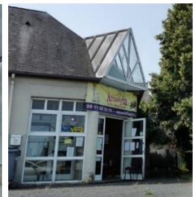
Enseigne en façade sous forme de bâche, peu qualitative – Beaumont-sur-Véron
