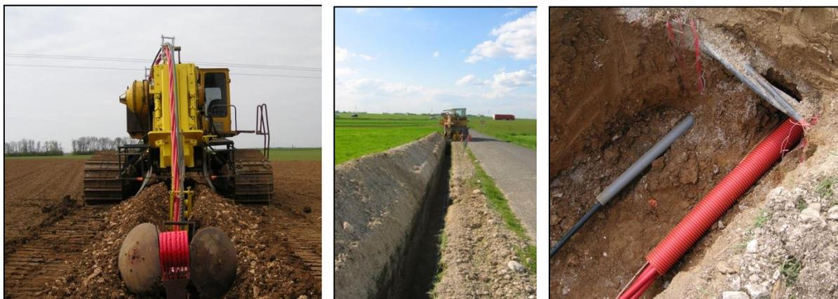
Figure 18 : Photos illustrant l'installation du câblage interne – Source : NORDEX
