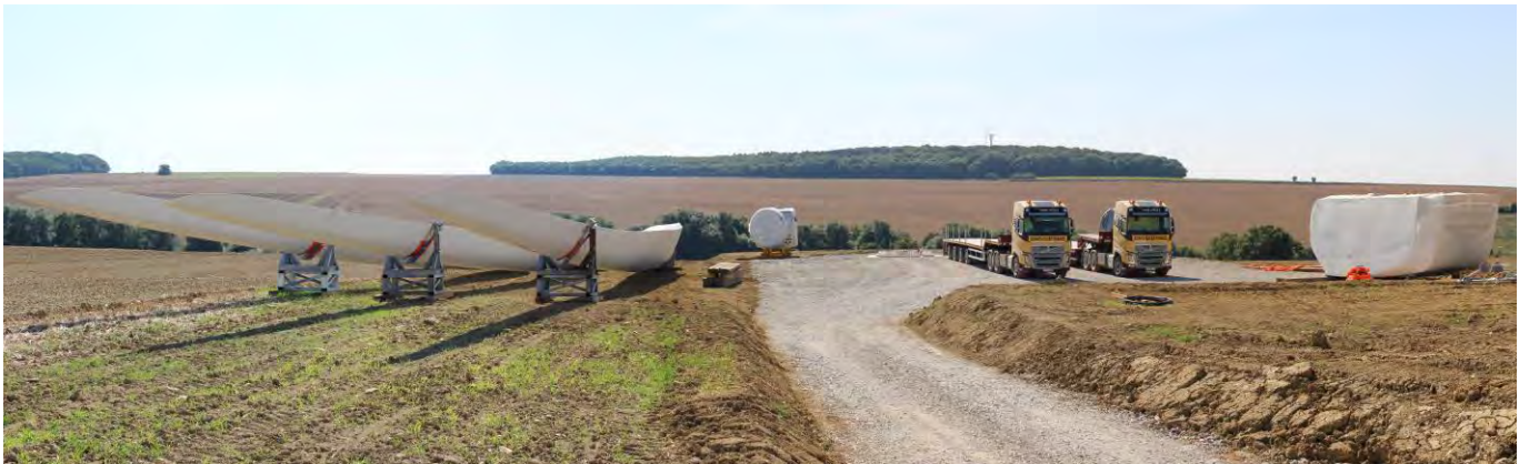
Éléments d'éoliennes avant montage (Source : Ora environnement)
