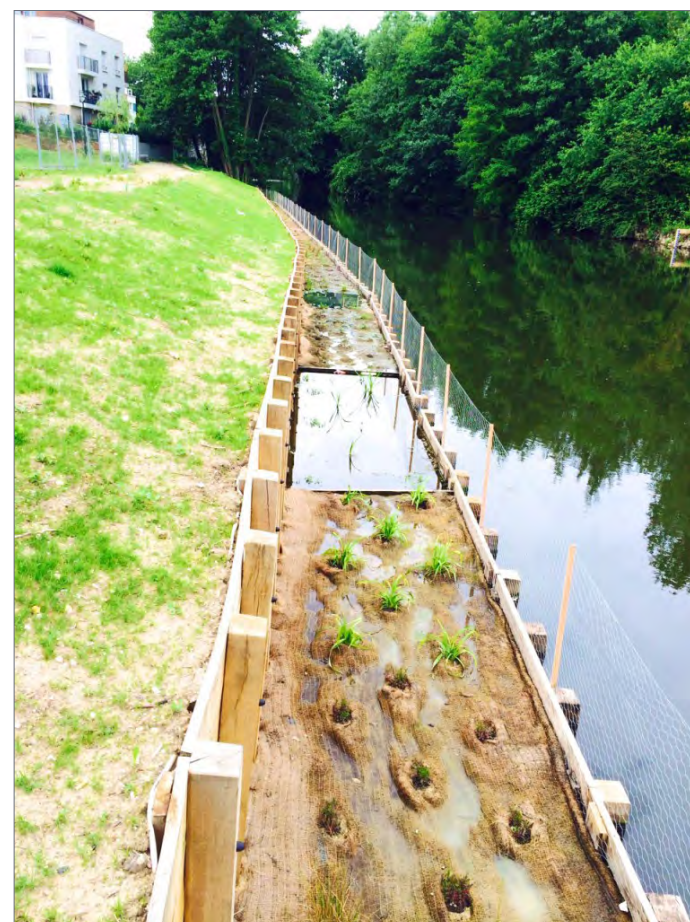
Figure 48 Exemple de confortement de berges en tunage bois planté
