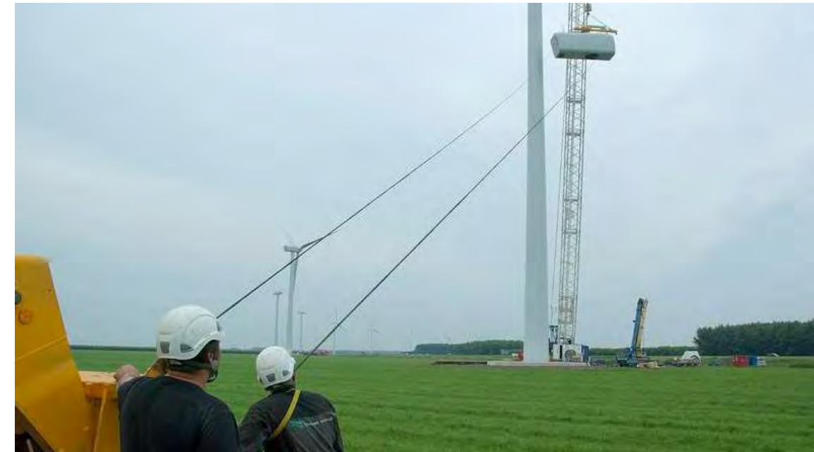
Photo 6 : Montage de la nacelle
