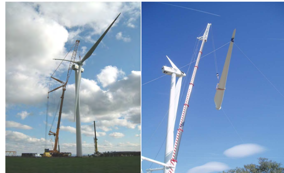
Photo 7 : Montage du rotor
