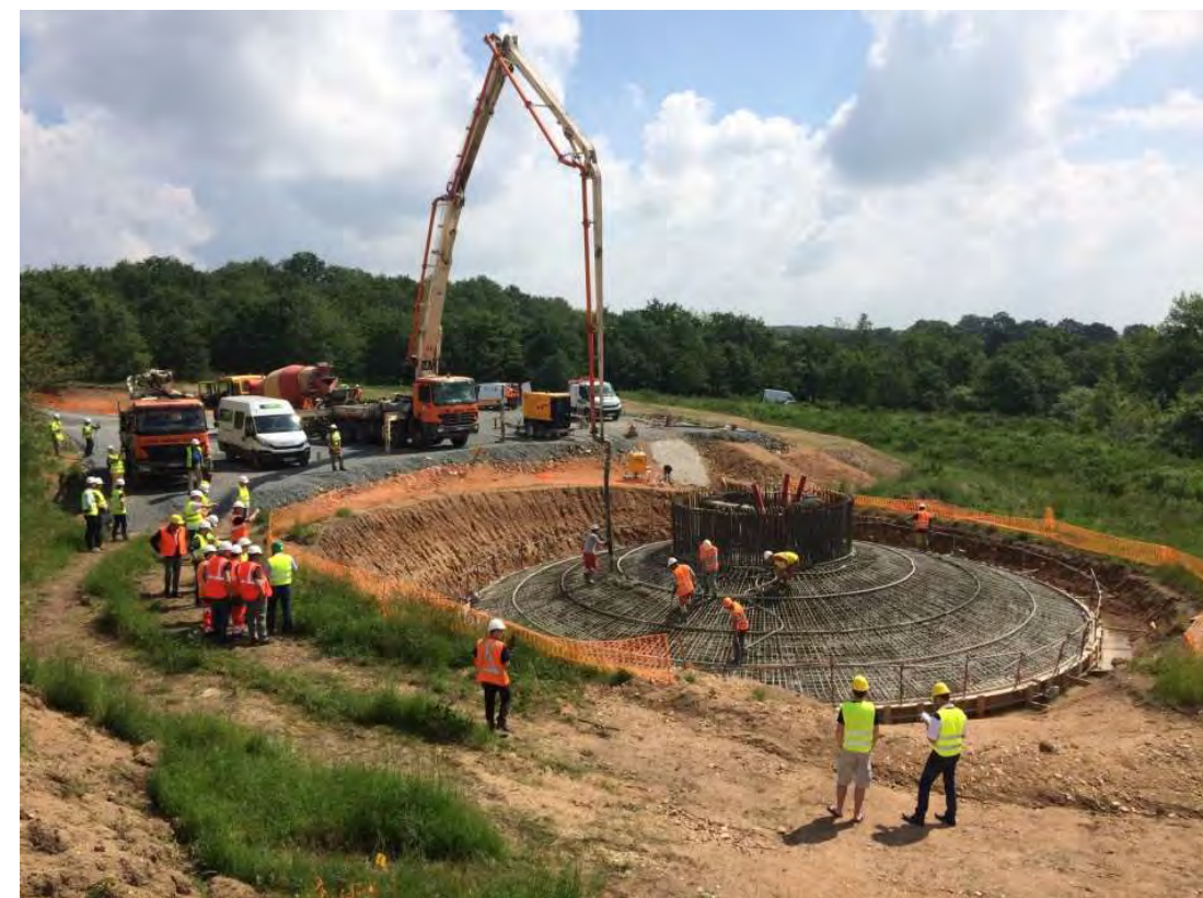
Photo 4 : Coulage du béton
