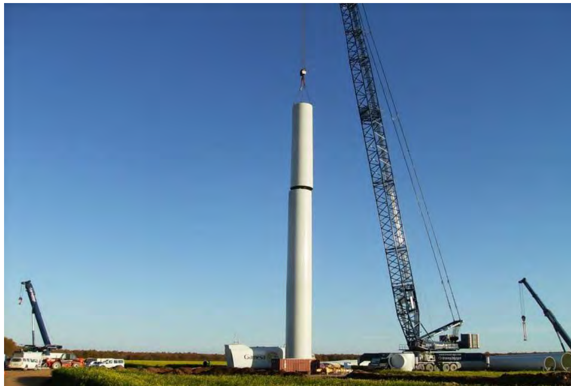
Photo 5 : Montage des éléments de la tour
