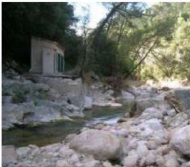
Vue d'ensemble de l'ancienne traversée n°2 et du poste de chloration (document IRH Ingénieur Conseil)
