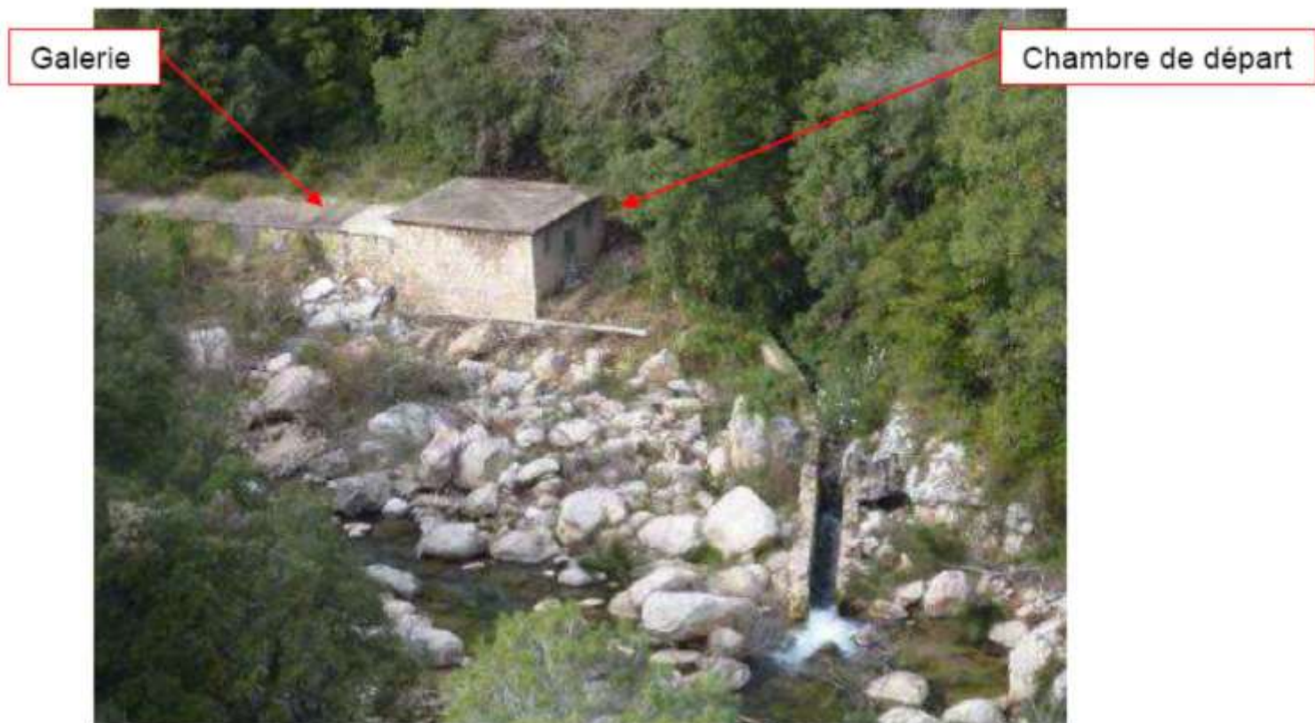
Bâtiment de captage (galerie + chambre de captage) - Document IRH Ingénieur Conseil
