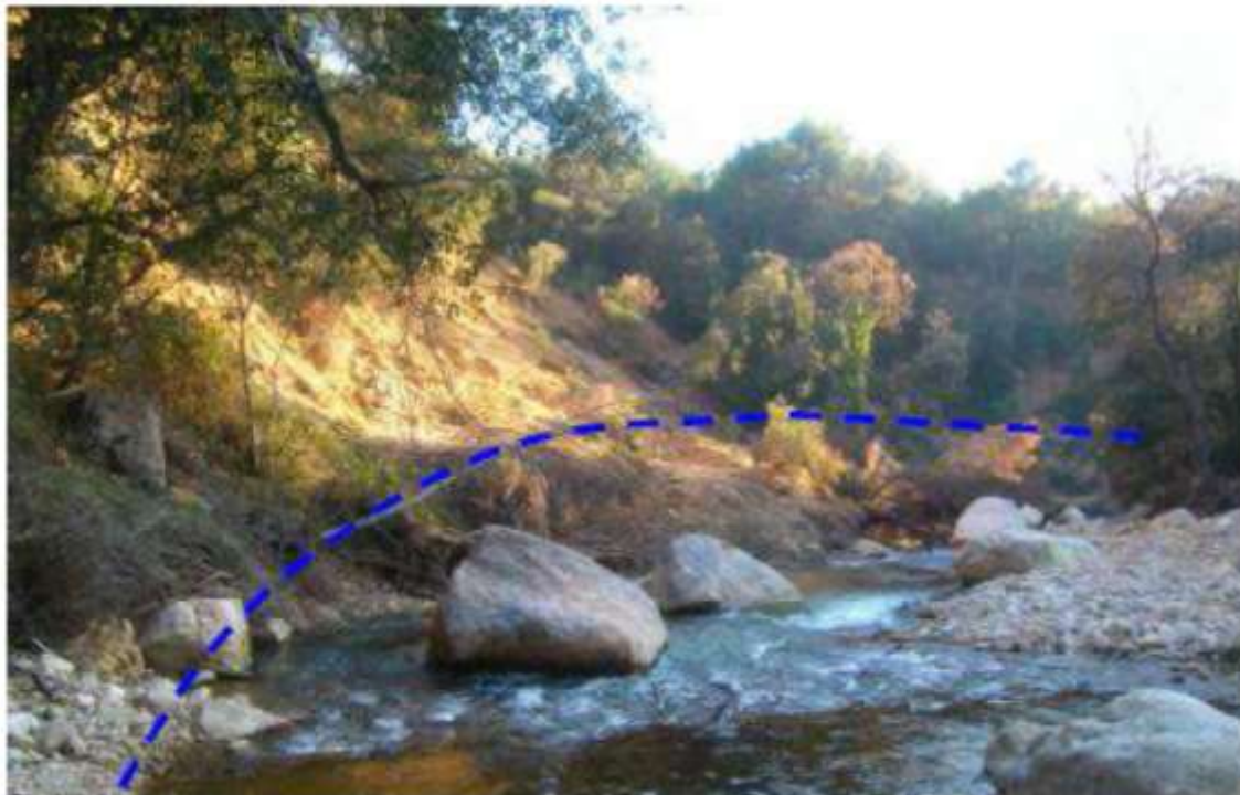
Lentille d'éboulement n° 2 (étude géotechnique G11, IMSRN)
