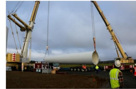
Une fois positionnée verticalement, la première partie du mât vient se fixer sur la partie émergente de l'insert.
