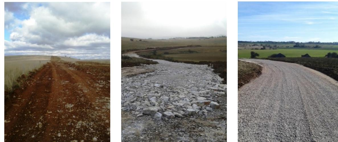
Figure : Opération de décapage ; mise en place de la couche de fond de forme ; mise en place de la couche de finition (source : Q ENERGY France)
