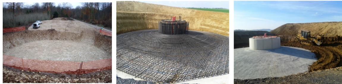
Figure : Réalisation des fondations ; phase d'excavation ; phase de ferrailage ; phase de remblaiement
