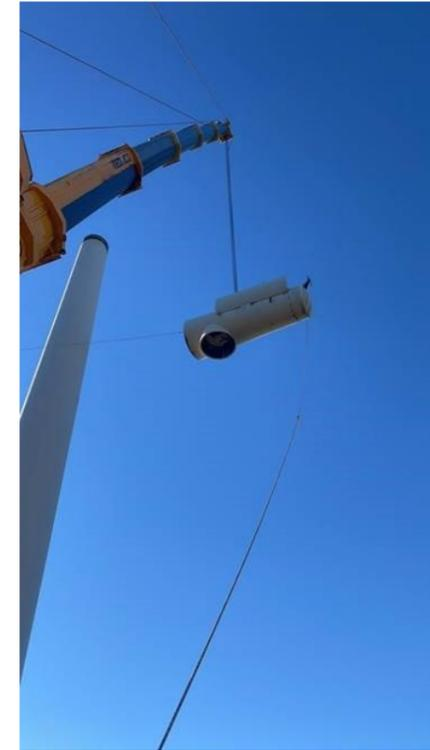
Figures : Démantèlement d'un parc éolien (source : Q ENERGY France)
