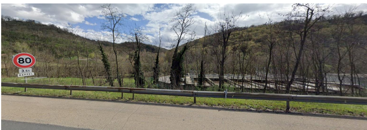
Figure 22 : Extrémité Est du site de la station d'épuration de Tartaras vu depuis l'A47 (prise de vue mars 2023)
