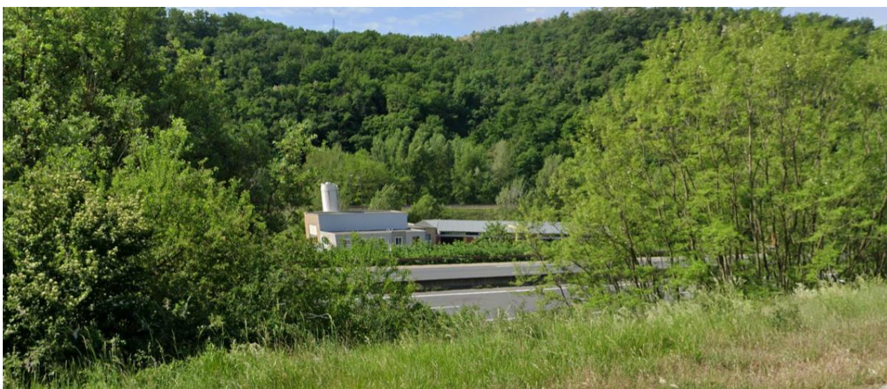
Figure 23 : Station d'épuration de Tartaras vue depuis la D488 (route de Givors) (prise de vue mai 2022)
