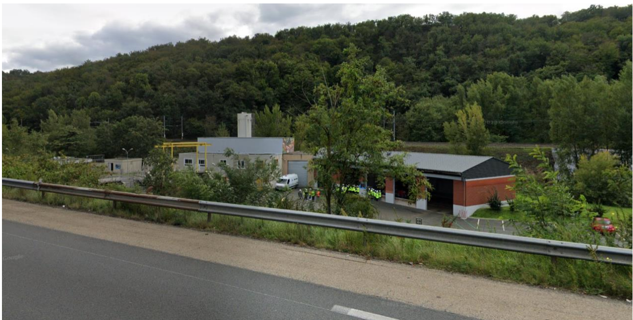
Figure 20 : Site de la station d'épuration de Tartaras vu depuis l'A47 (prise de vue septembre 2022)
