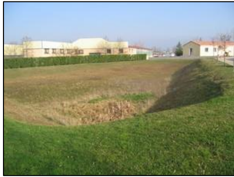
Figure 13 : Bassin de rétention en forme de noue
