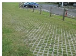
**Les aires de stationnement** peuvent également recourir à des sols drainants stabilisés mécaniques. **Les aires de stationnements** sont plantées et sont perméables quel que soit leur dimension.
