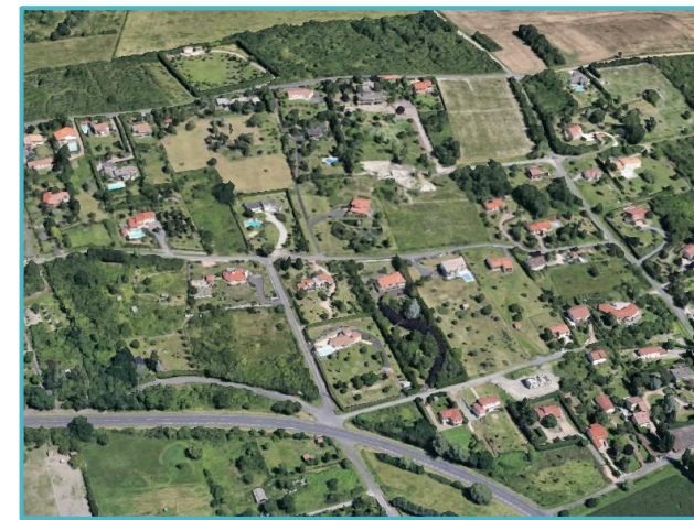
Nord-Ouest de Riom ©Google Earth
