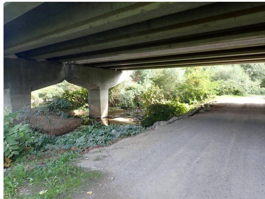
Photo n°31. Passage sous l'A89 de la Dore
