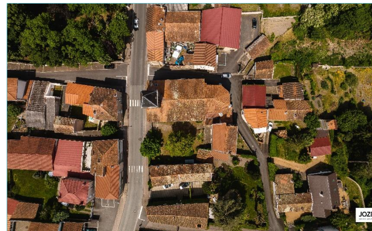
Toitures à Joze - © Florian Bompan
