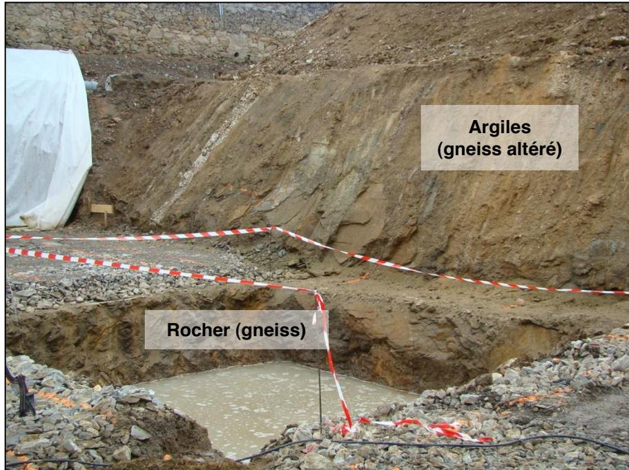
**Figure 4 :** Affleurement de gneiss avec une altération argileuse sur un chantier en face de la gendarmerie
