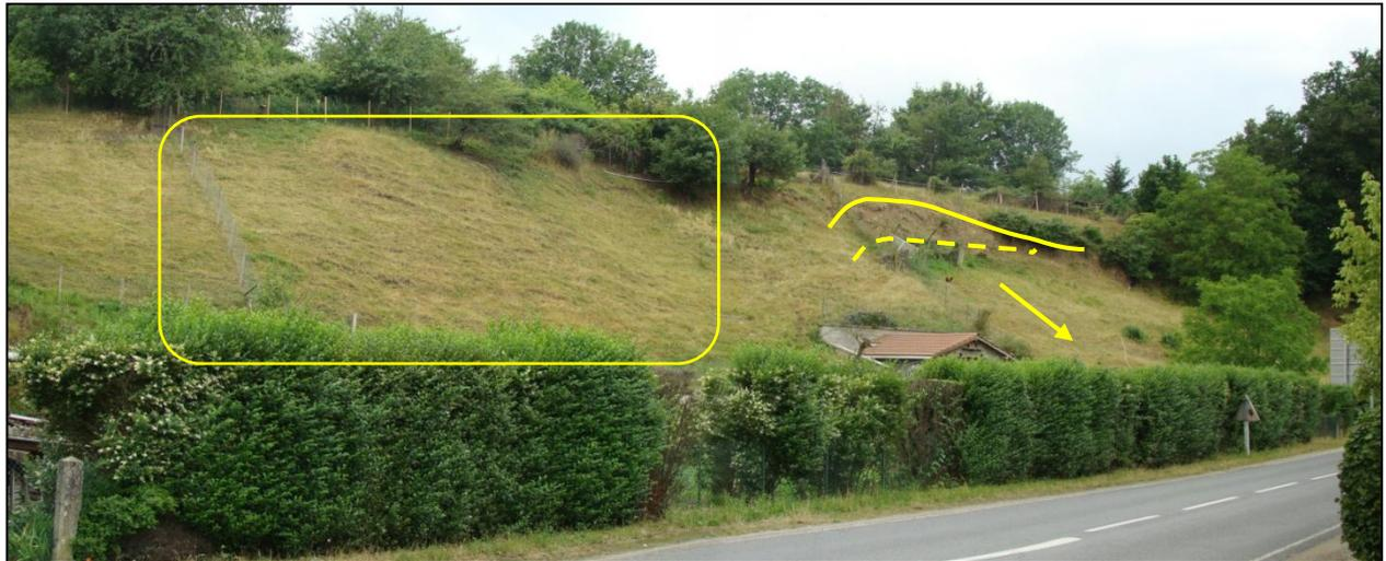
**Figure 16 :** Talus présentant des instabilités (ondulations à gauche et niche d'arrachement à droite), en face du parking du bouldrome [Source : IMS<sub>RN</sub>]
