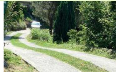
*Bandes de roulement en béton, enherbement central*
