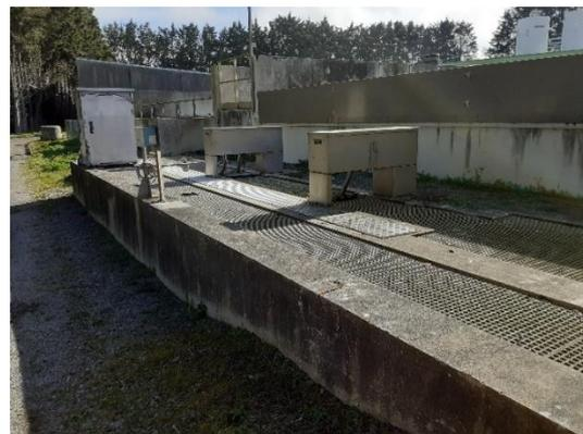
*Canal de comptage et réacteur UV sortie boues activées*
