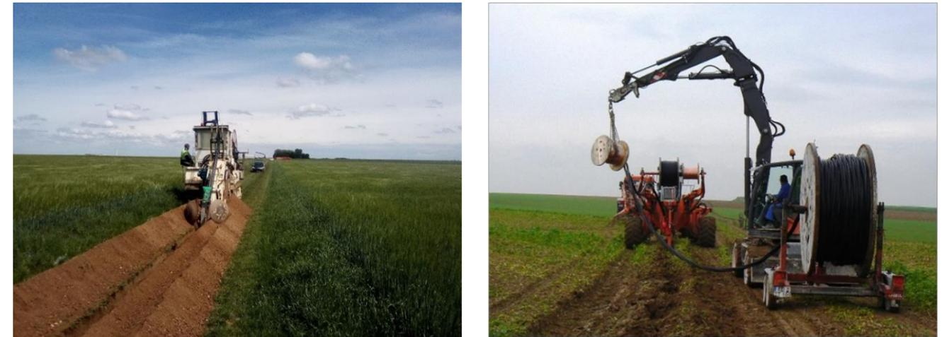
Photo 6 : Tranchée pour le passage de réseau électrique HTA à partir d'une trancheuse (à gauche) et d'un soc tracté (à droite)
