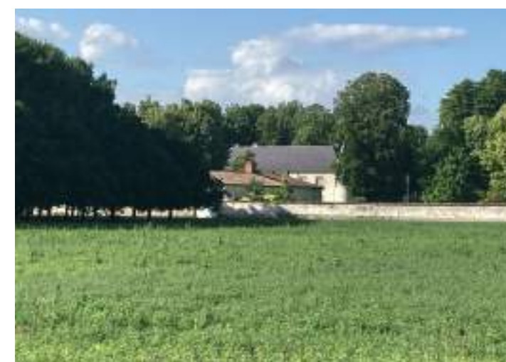
Château de Villers-le-Château
