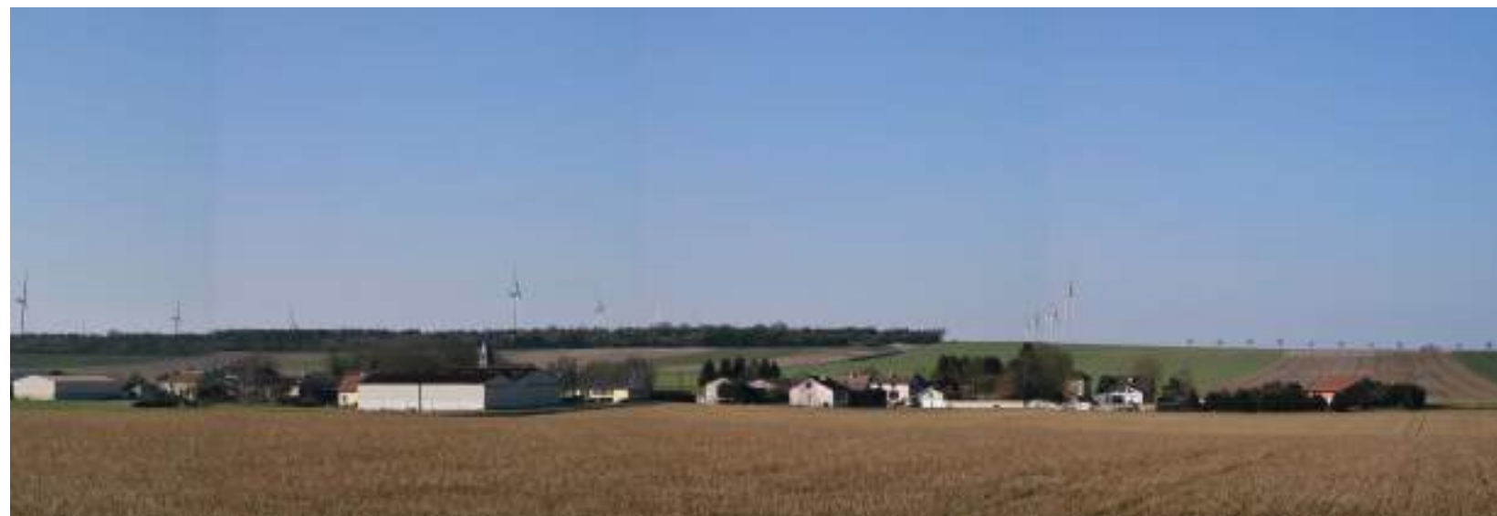
La silhouette bâtie du village de Cheniers rentre déjà en interaction visuelle avec le parc en exploitation de Thibie avec un phénomène d'effet de surplomb sur les habitations du village. L'église de petite taille émerge à peine au milieu des grands bâtiments d'exploitation.
