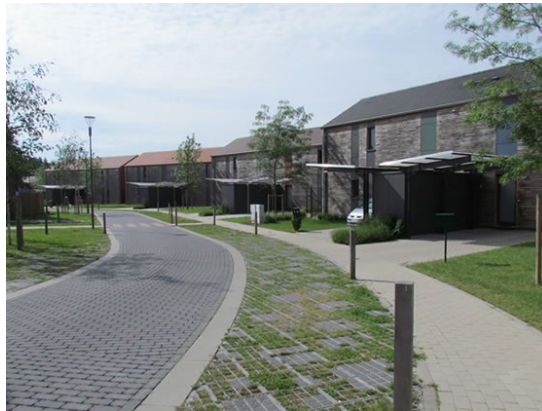
Exemple de stationnement perméable ©O2D Environnement
