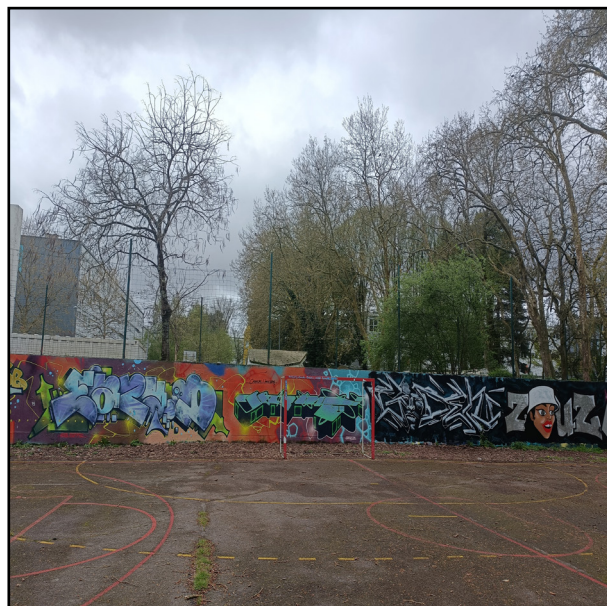
Le mur ouest qui clôture l'actuel Ecopoint
