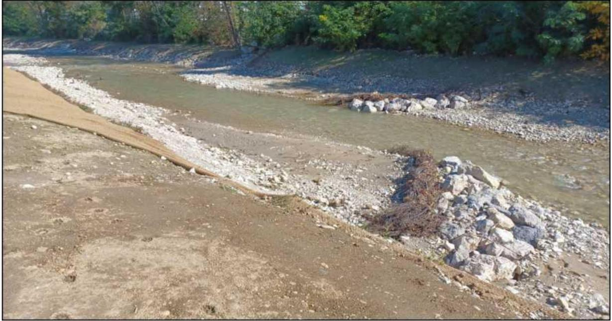
**Figure 25 :** Exemple des épis à mettre en œuvre
