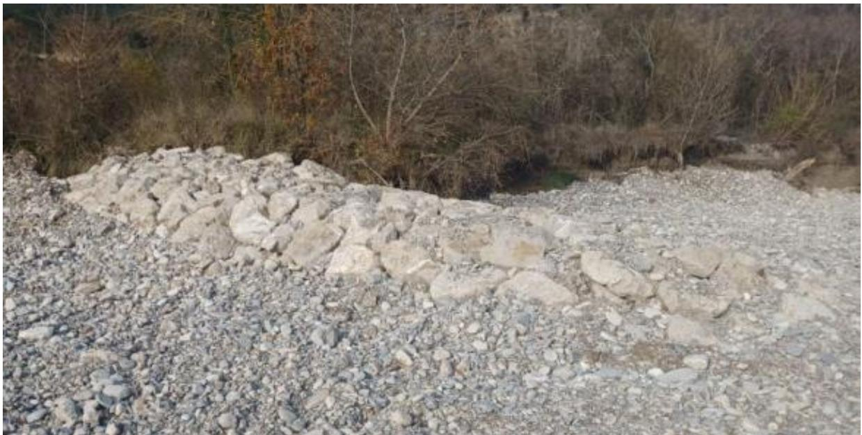
**Figure 26 :** Exemple des épis en enrochement
