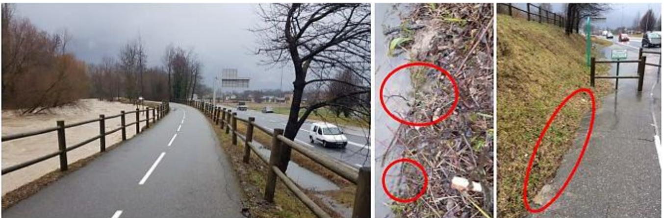
**Figure 10 :** Vue de la digue rive au droit du coude de Villarcher et venues d'eau (cerclées en rouge) au pied de la digue au pic de la crue du 4 janvier 2018.
