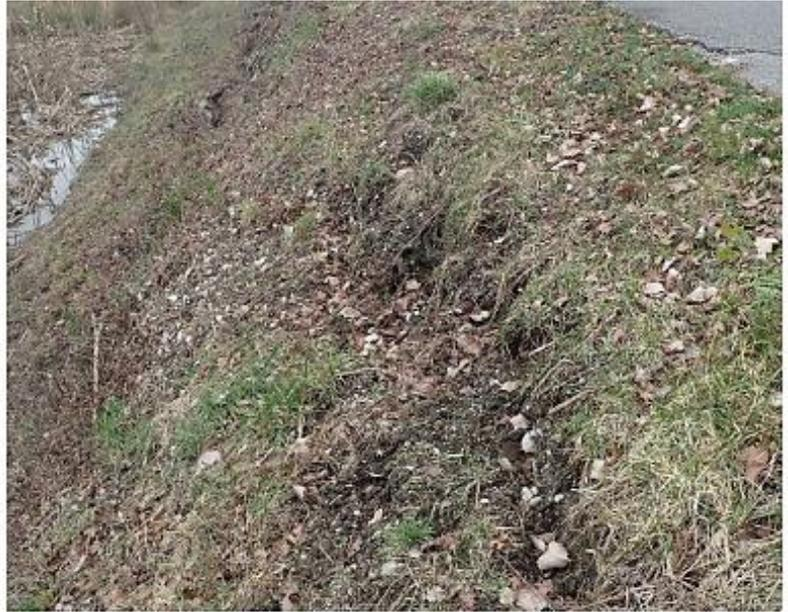
**Figure 11 :** Fissure sur le talus amont rive droite survenue en février 2020 au point kilométrique 5.85
