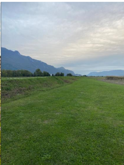
Figure 4 : Bras de décharge
